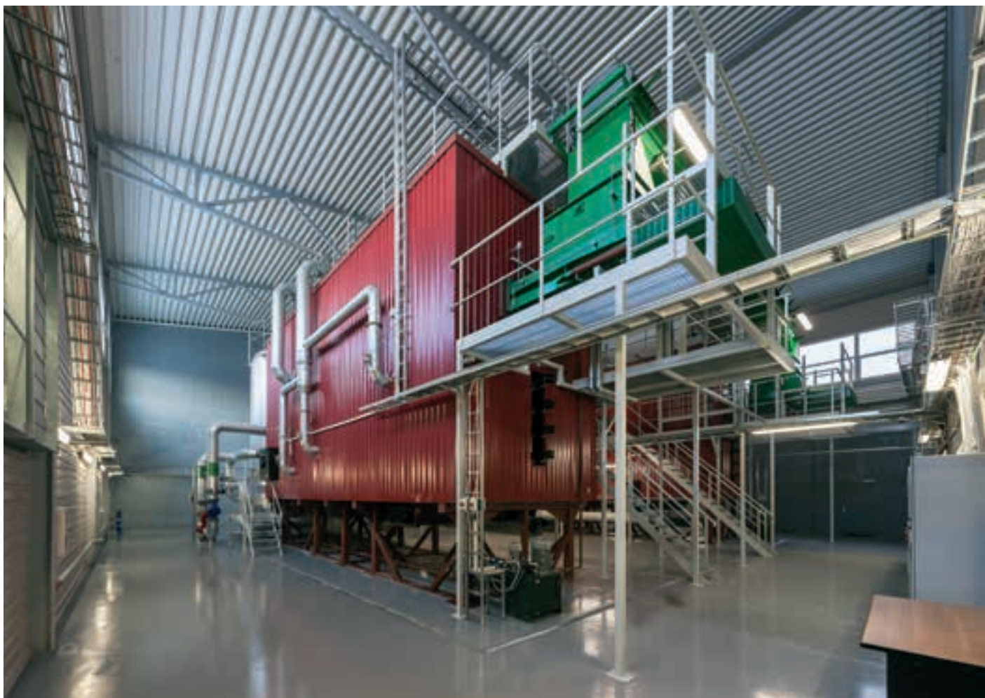
Erhalt eines Querverbands mittels BHKW
